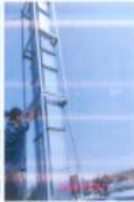
锅炉废气排放口
